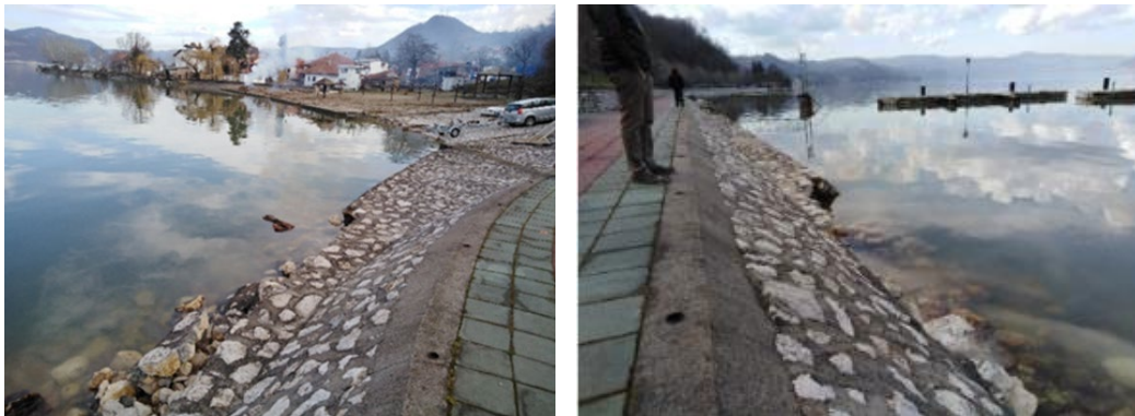
Слика 18. Оштећења на обалоутврди (лево) и понтонима (десно) у Доњем Милановцу
