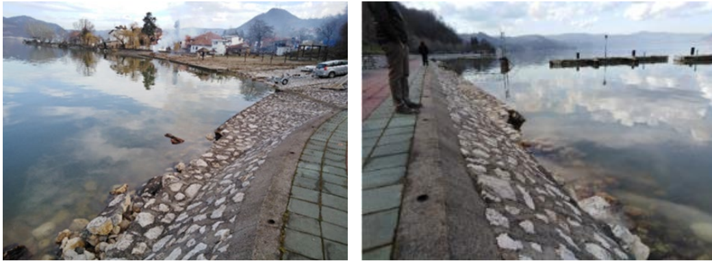
Слика 5. Оштећења на обалоутврди (лево) и понтонима (десно) у Доњем Милановцу
